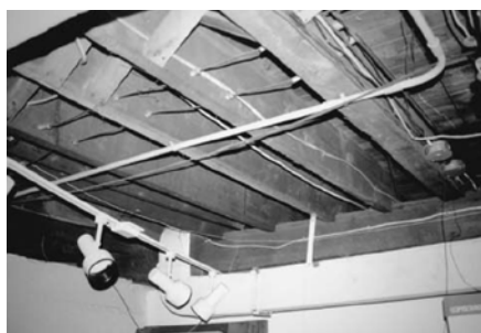
Figura 1. Ejemplo de vigas no protegidas en el cielo raso de un sótano.
