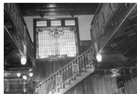
Figura 2. Las escaleras abiertas permiten que el fuego y el humo se extiendan con rapidez.
