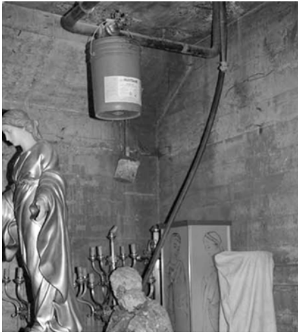
Figura 4. Filtración de agua desde una tubería sanitaria.
