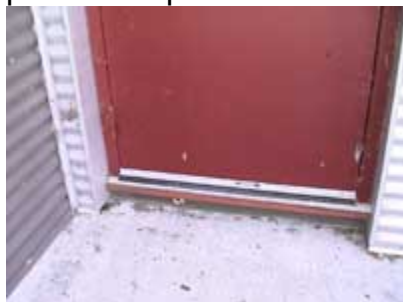
Figura 7. La instalación de un efectivo burlate en una puerta exterior reduce enormemente la posibilidad de que las plagas entren a la estructura, a pesar de la alta actividad de insectos y arañas existente bajo una iluminación nocturna. De todas formas se requiere una mejor limpieza, ya que se puede observar algunos residuos cerca de la puerta.
