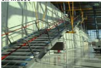
Nivel 6. Instalación de archivo nacional diseñada como del tipo “edificio dentro de un edificio”
