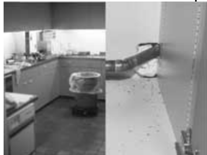
Figura 11. Las cocinas son lugares atractivos para los roedores, los cuales pueden ingresar a través de alguna tubería no ajustada correctamente o arrastrándose por debajo de las puertas. La mayoría de los problemas de roedores se asocian a los alimentos de las personas en los edificios. A la derecha de la foto se pueden observar heces de ratones en la despensa. El orificio de acceso ha sido ineficazmente taponado con papel arrugado.
