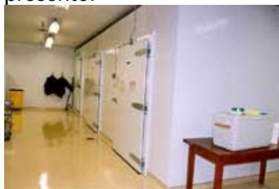
Figura 9. Tanto los congeladores horizontales como las cámaras frigoríficas pueden ser utilizados para desinfestar la mayoría de los objetos de una colección. Dependiendo de la situación, otros sistemas también pueden ser implementados en un grado que varíe de una escala menor a una mayor, según el tamaño y cantidad de los objetos. Fotografía: R. Kigawa.
