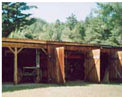
Nivel 2. Cochera con suelo de gravilla
