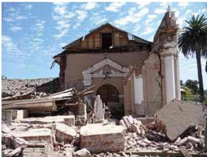
Foto 6: Iglesia de la Hacienda San José del Carmen del Huique, VI Región, Provincia de Colchagua.
