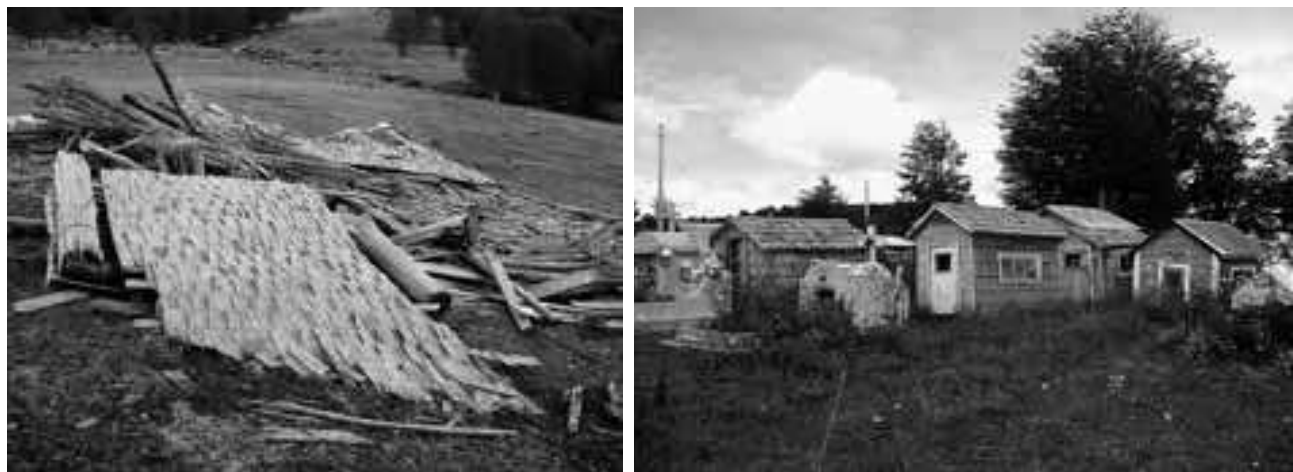
Fotos 5: Construcciones en base a tejuelas artesanales de lenga ( N. pumilio ). De izquierda a derecha: casa desmoronada (construida en 1940), Cerro Negro, provincia de Coyhaique. Nichos en cementerio rural, Lago Pólux, provincia de Coyhaique.
