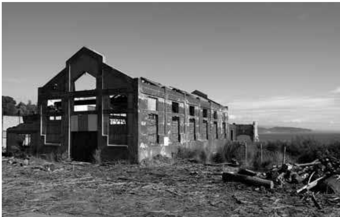
Foto 4: Paisaje industrial correspondiente a instalaciones de Enacar. El deterioro de los inmuebles demuestra que el valor cultural e histórico de dichas edificaciones y su entorno, no ha sido adecuadamente percibido por todos los actores.
