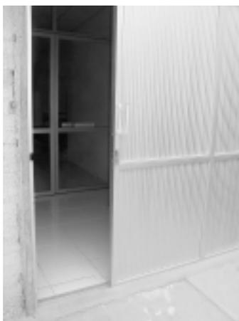
*Foto 10. Puerta de aluminio acanalado, de corredera doble, con aislante, permite un control de su abertura al ingreso, evitando los cambios bruscos del medio ambiente.*
