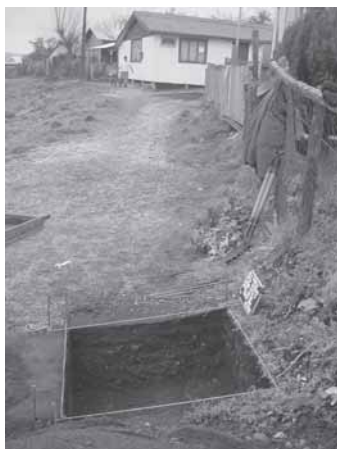
Foto 7: Pozo de sondeo realizado en una de las áreas de circulación de la Puntilla.
