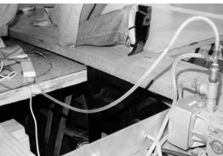
Foto 8: Conexión de la bomba al tablero.
