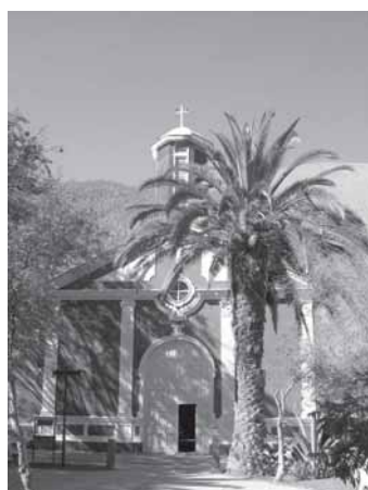
Iglesia de Diaguitas después de la restauración.
