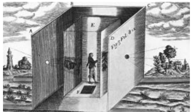
Cámara oscura diseñada por Kircher (1601-1680)
