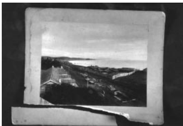
Soporte en malas condiciones
