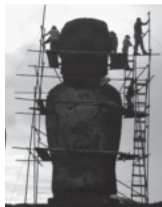
Foto 6. Durante los trabajos de instalación de protección.
