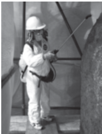
Foto 9. Aplicación del hidrorrepelente.
