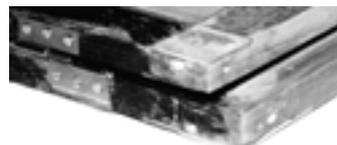
**Foto 6.** Detalle que muestra una bisagra del sistema de cuatro, que permite retirar las aletas levantándolas hacia arriba de las bisagras internas que las sostienen. Puede apreciarse también el armado de las piezas en esquina con tarugos diagonales y una placa de refuerzo en el ángulo.
