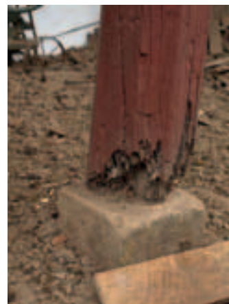
Foto 6: Detalle de la base de una columna de madera en los corredores de la Hacienda de Huilquilemu.
