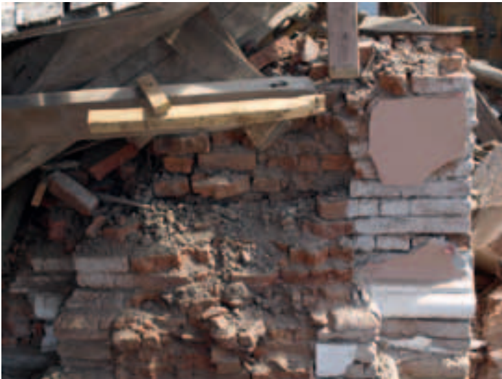
Foto 12: Vista de los daños en una de las salas del Museo Regional de Rancagua (derecha).
