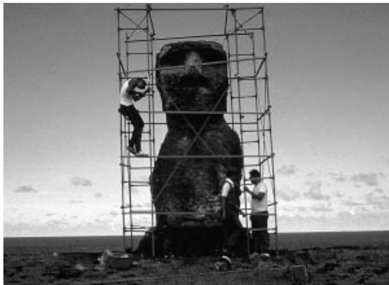
Foto 13. Moai Hanga Kio 'E. Construcción de la estructura para aislarlo del agua de lluvia.
