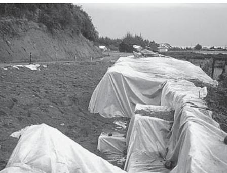
Foto 8. Relleno sobre el geotextil con sedimentos.
