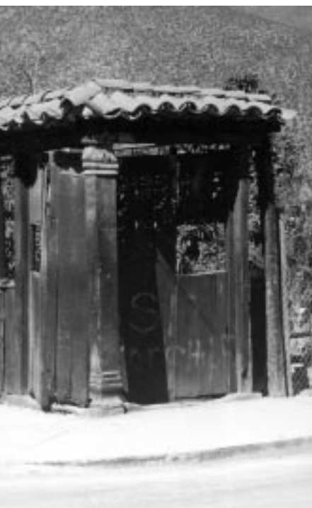
Foto 2: Pórtico colonial en la Plaza de Petorca. Esquinero típico de la arquitectura colonial chilena que permitía la accesibilidad al solar original, pudiendo pasar de una calle a otra por su interior. Este en particular aún conserva amarras con cuero animal.
