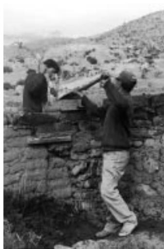
Foto 5: Técnica actual de construcción con moldes para adobes in situ , Pedernal.
