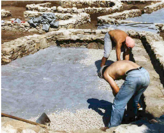
Figura 5. Construcción del sistema de drenaje en el poblado fortificado de Cossourado, municipio Paredes de Coura. Se utilizó geotextil, grava y sedimentos salidos de la excavación arqueológica (Fotografía: Silva, M. de F. M. da 2013). Construction of the drainage system on the hill fort of Cossourado, Paredes de Coura municipality. Geotextile, gravel and sediment from the archaeological dig were used (Photograph: Silva, M. de F. M. da 2013).
