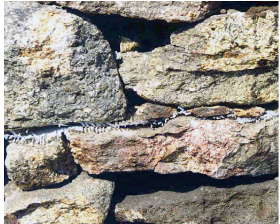
Figura 6. División entre el muro preexistente y la parte reconstruida, mediante fibra de geotextil sintético en una de las estructuras del poblado de Cossourado (Fotografía: Silva, M. de F. M. da 2013). Separation between the preexisting wall and the reconstructed section, made with synthetic geotextile fibre in one of the structures of Cossourado village (Photograph: Silva, M. de F. M. da 2013).
