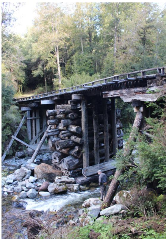
**Figura 9.** Puente en el sector de Chan Chan, comuna de Panguipulli, Chile. Construido con madera nativa, caracterizado por pilar central de troncos encastillados, tablero de madera, refuerzos y barandas (Fotografía: Archivo CMN, 2016).
