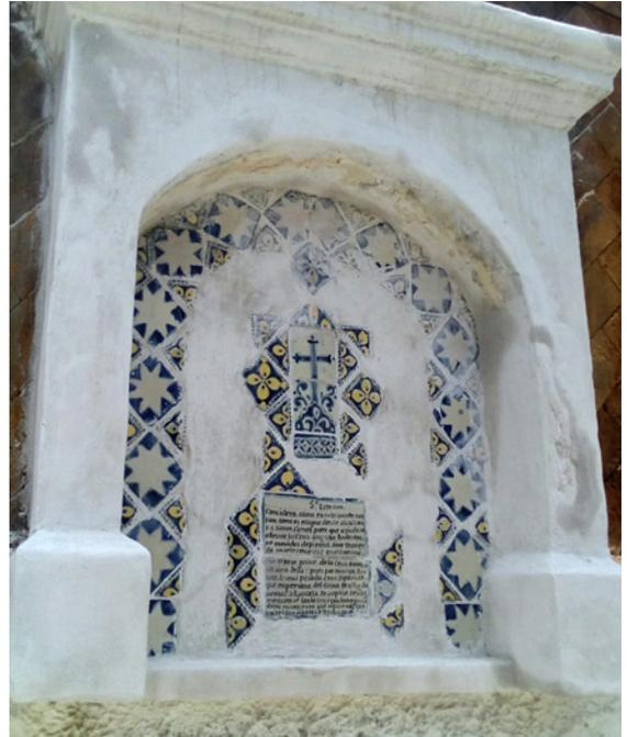
**Figura 8.** Detallado de nicho: resanes y definición de perfiles previo a la aplicación de pintura (Fotografía: Hernández, A. 2017).
