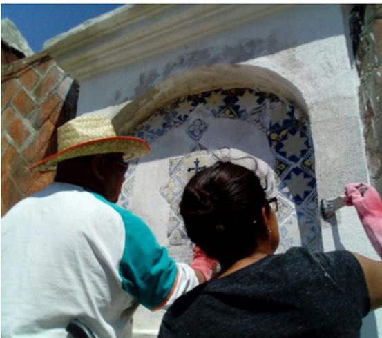
**Figura 9.** Aplicación de acabado fino: mezcla cal-arena en proporción 1:1 (Fotografía: Hernández, A. 2017).
