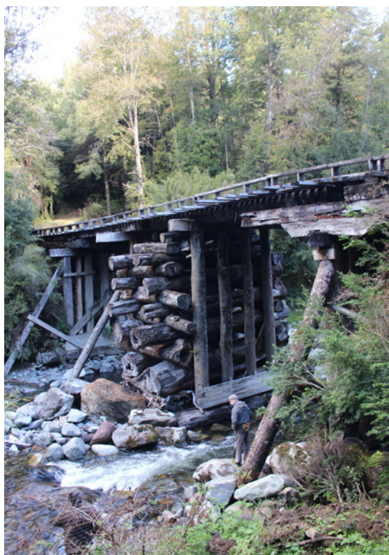
Figura 9. Puente en el sector de Chan Chan, comuna de Panguipulli, Chile. Construido con madera nativa, caracterizado por pilar central de troncos encastillados, tablero de madera, refuerzos y barandas (Fotografía: Archivo CMN, 2016). Bridge in Chan Chan area, Panguipulli municipality, Chile. Built with native wood, characterized by a central pillar of castellated beams, wooden deck, reinforcements and railings (Photograph: Archive CMN, 2016). Ponte na localidade de Chan Chan, município de Panguipulli, Chile. Construído com madeira nativa, caracteriza-se pelo pilar central de troncos encastelados, tabuleiro de madeira, reforços e grades (Fotografia: Arquivo CMN, 2016).
