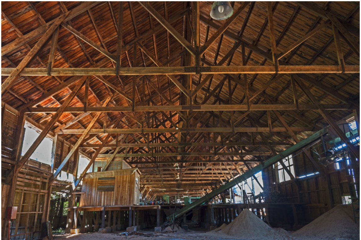
Figura 5. Galpón de planta libre, con techo a dos aguas, construido con madera nativa. Presenta cerchas a la vista que conforman la estructura del techo, con más de 100 m de largo (Fotografía: Archivo CMN, 2016).
