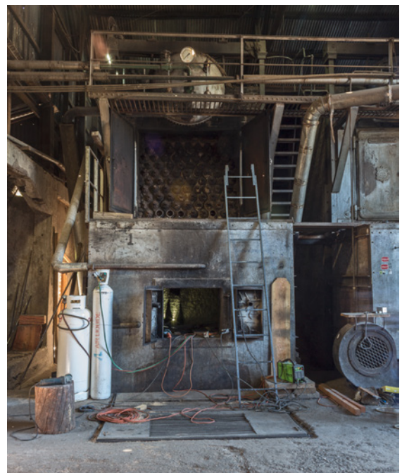
Figura 6. La caldera es un sistema que consta de dos cámaras construidas en hierro fundido, que se conectan a dos hornos de ladrillo por medio de tuberías y tirajes, con puerta de cierre metálica, pasarelas y escotillas (Fotografía: Archivo CMN, 2016).
