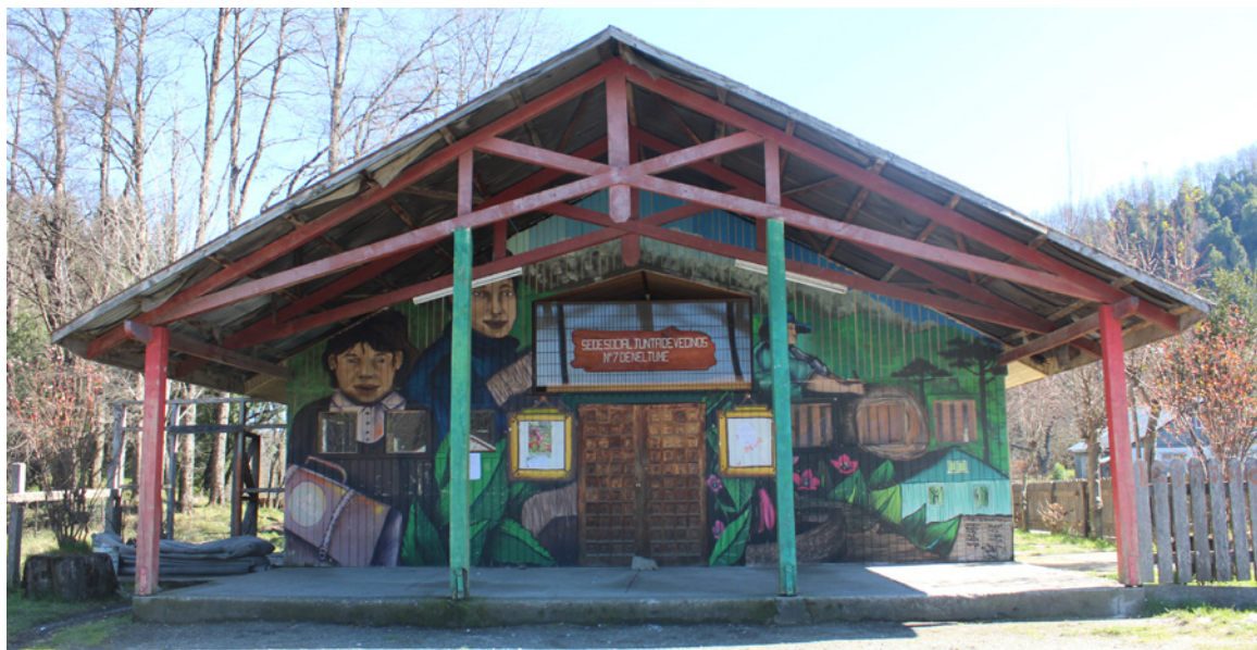
Figura 8. Expulpería del complejo industrial, emplazada en el área cívico-administrativa de la localidad. Se caracteriza por un volumen simple, con acceso techado y cubierta a la vista compuesta por cerchas de madera (Fotografía: Archivo CMN, 2016). Former “pulperia” (store) of the industrial compound, located in the civic-administrative area of the town. It is characterized by its simplicity; its entrance has an exposed roof with wooden beams (Photograph: CMN Archive, 2016). Antiga “pulperia” do complexo industrial, localizada na área cívico-administrativa da localidade. Caracteriza-se por um volume simples, com acesso coberto com vigas de madeira expostas (Fotografia: Arquivo CMN, 2016).
