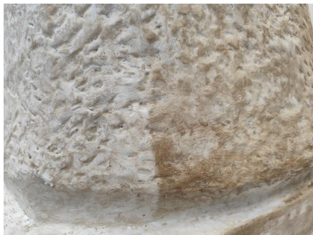
Figura 37. Detalle de limpieza superficial con soluciones tamponadas (Fotografías: Salazar, N. 2025. Archivo CNCR. ID. 5272).
